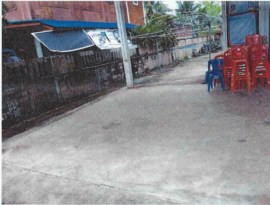
รูปลานกีฬา บ้านใหม่หลวง หมู่ ๔
